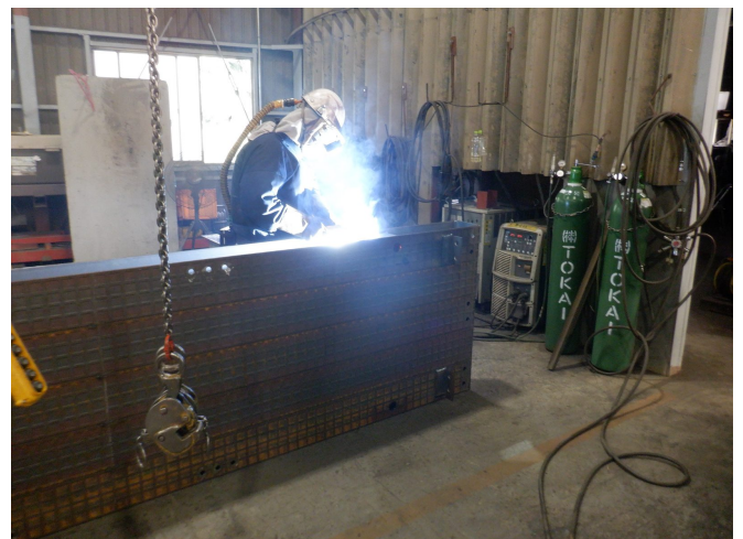
長尺部材の溶接施工
