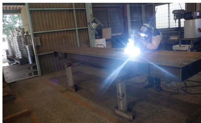
開先を確認しながらの本溶接
