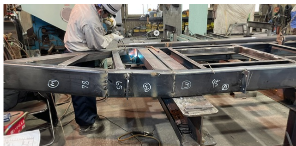
鉄骨架台の組立・溶接
