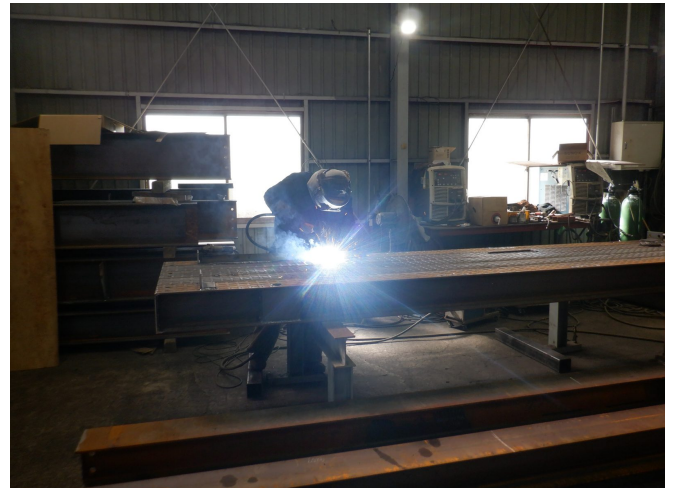
接合部の本溶接
