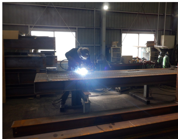
定盤の上でH形鋼を本溶接する作業
