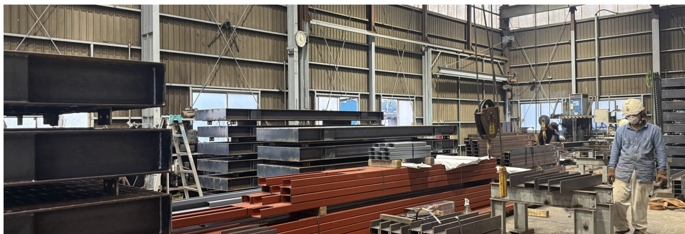
本社工場内。段積みした柱と、錆止め塗装を終えた梁・小梁
