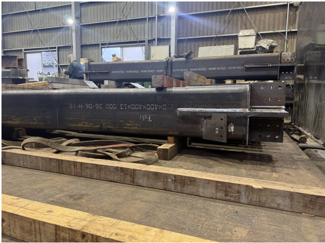
ブラケットを取り付けた角形鋼管柱
