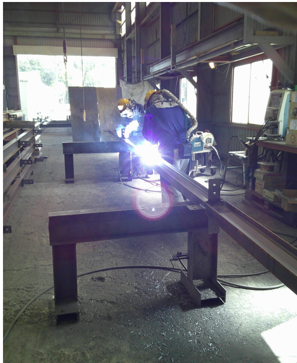
本社工場（茨城県小美玉市）での溶接作業
